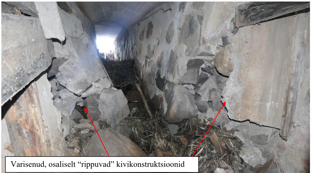
Foto 12. Veskikanal, vaade turbiinikambrist ülesvoolu (30.04.2020)
