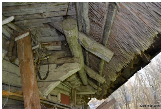
Foto 252. Koovi aida katusekonstruktsioon. Foto Mart Hiob 2016.
