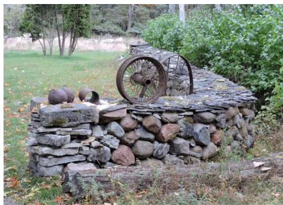
Foto 64. Ümber laotud kiviaed Vilsandi külas Kaheveskil (ülal) ja Koplil (all). Mõlema puhul on kasutatud nii pae- kui maakive. Fotod Mart Hiob 2015.
