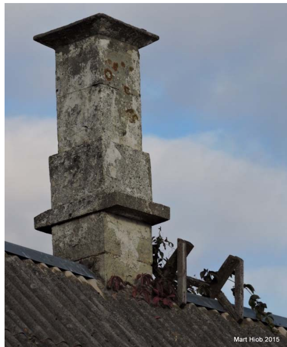
Foto 32. Kusti elamu korsten. Foto Mart Hiob 2015.
