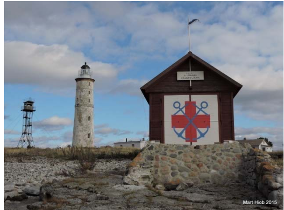
Foto 56. Nõukogudeaegne piirivalve torn, Vilsandi tuleorn ja merepääste paadikuur Vilsandi tuleorni kompleksis. Foto Mart Hiob 2015.
